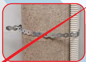
Ispravno i neispravno postavljanje fleksibilnog creva na stub
